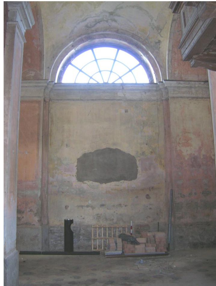
Particolare navata centrale e navata laterale sx
