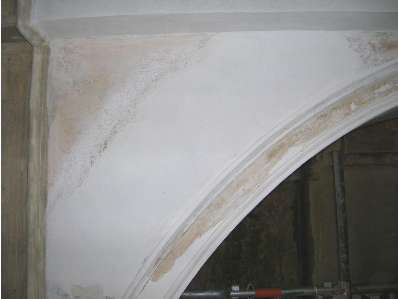
particolare arcata navata centrale, ricostruzione piano di fondo e modanature
