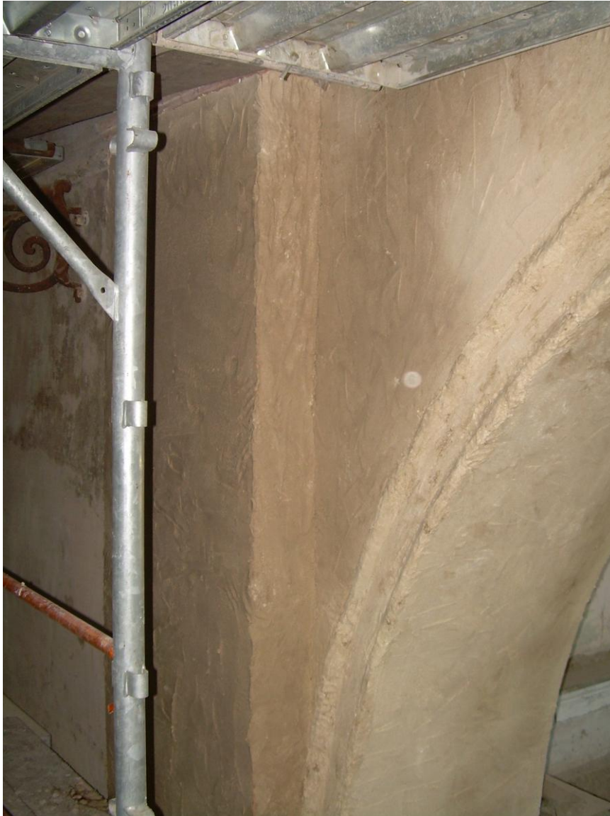
particolare arcata navata centrale
